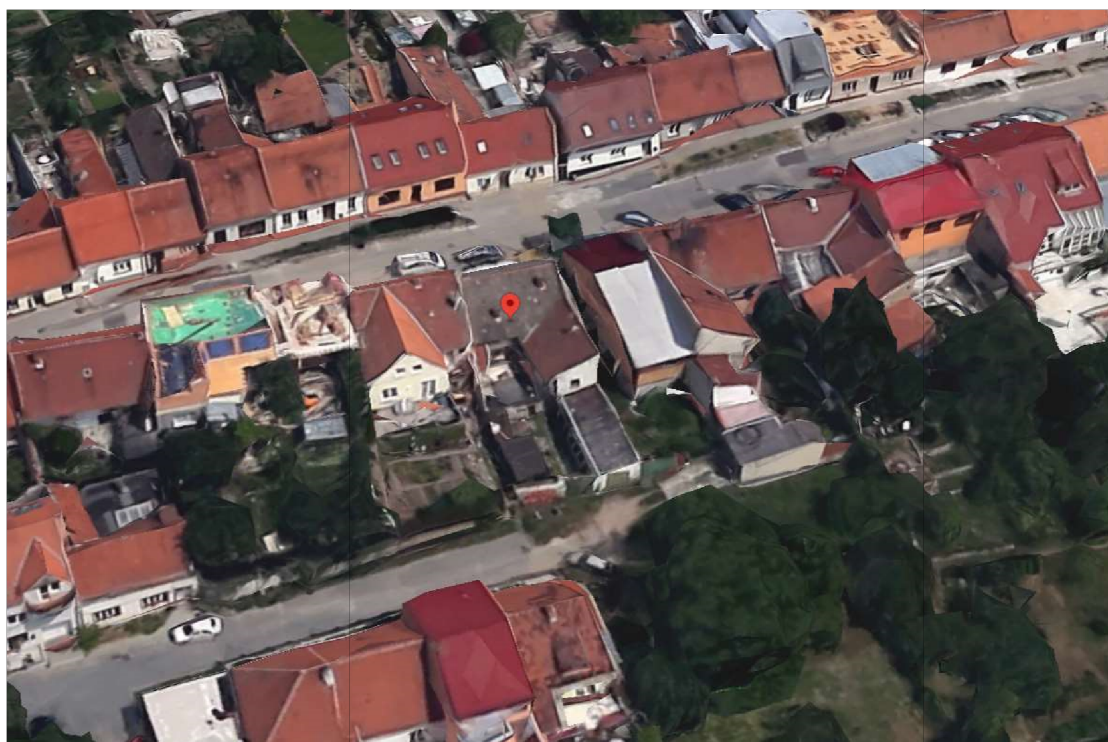
Stávající objekty na pozemku investora
